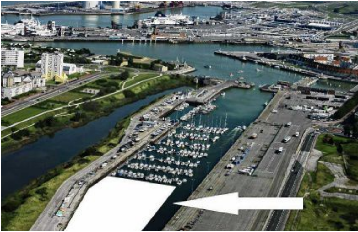
C'est au fond du port, là où ont été installés des anneaux provisoires lors du chantier de réfection des quais, que 100 nouveaux anneaux seront installés.
